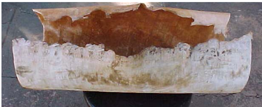
Figura 2.19 – Capa externa apresentando ruptura total da parede, FRANCO, (2001).
