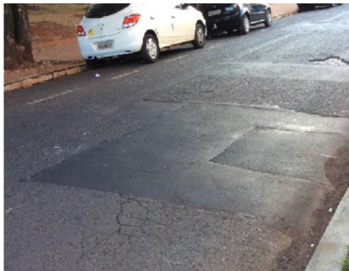
Figura 19 - Exemplo de Remendo
