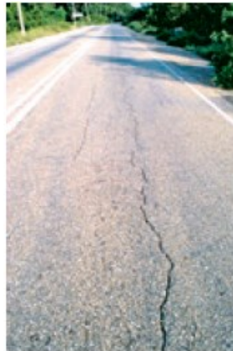
Figura 7 - Exemplo de Trinca Longitudinal Longa
