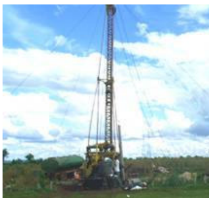
Poço 7: Maquinário para a perfuração
