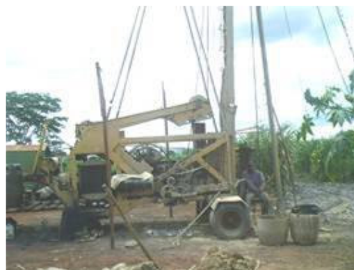
Poço 8: Maquinário para a perfuração
