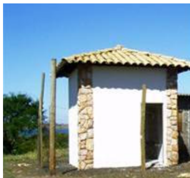
Poço 1: Casa de proteção
