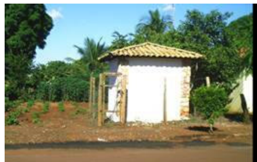
Poço 6: Casa de proteção
