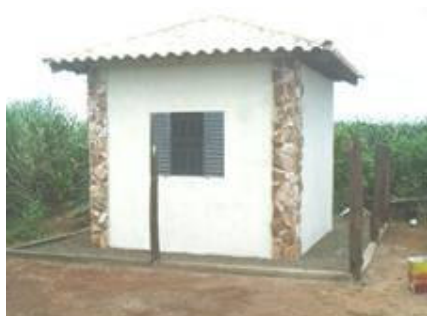
Poço 5: Casa de proteção
