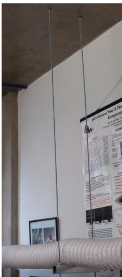
Figura 17 – Sistema de fixação.
