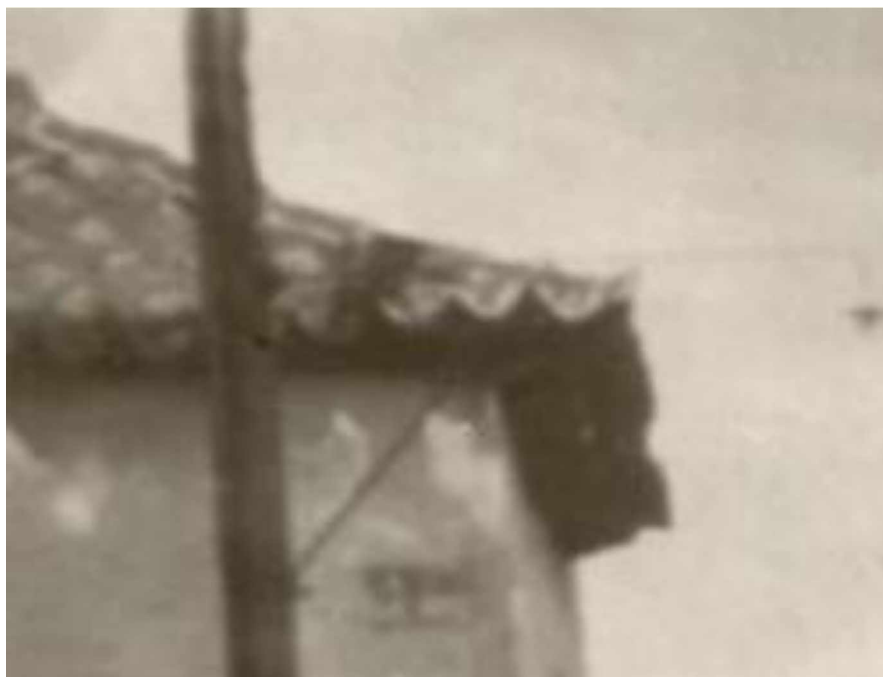
Figura 6: Beirais simples e telhas de capa e canal que compunham a obra. Rua José Ayube, início dos anos 1920. (Detalhe)
