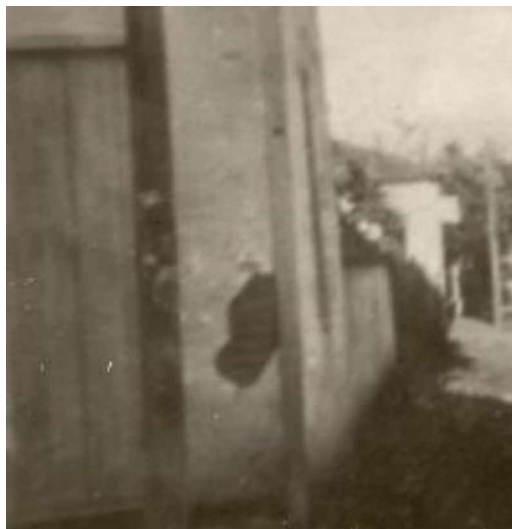
Figura 5: Revestimento em adobe e esteio em madeira aparente. Rua José Ayube, início dos anos 1920. (Detalhe)
