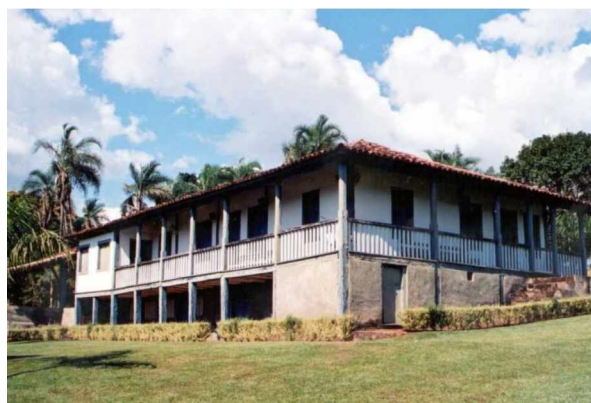
Figura 2: Fazenda São Francisco, já sem o cômodo lateral e com as varandas interligadas. Nov./2000.
