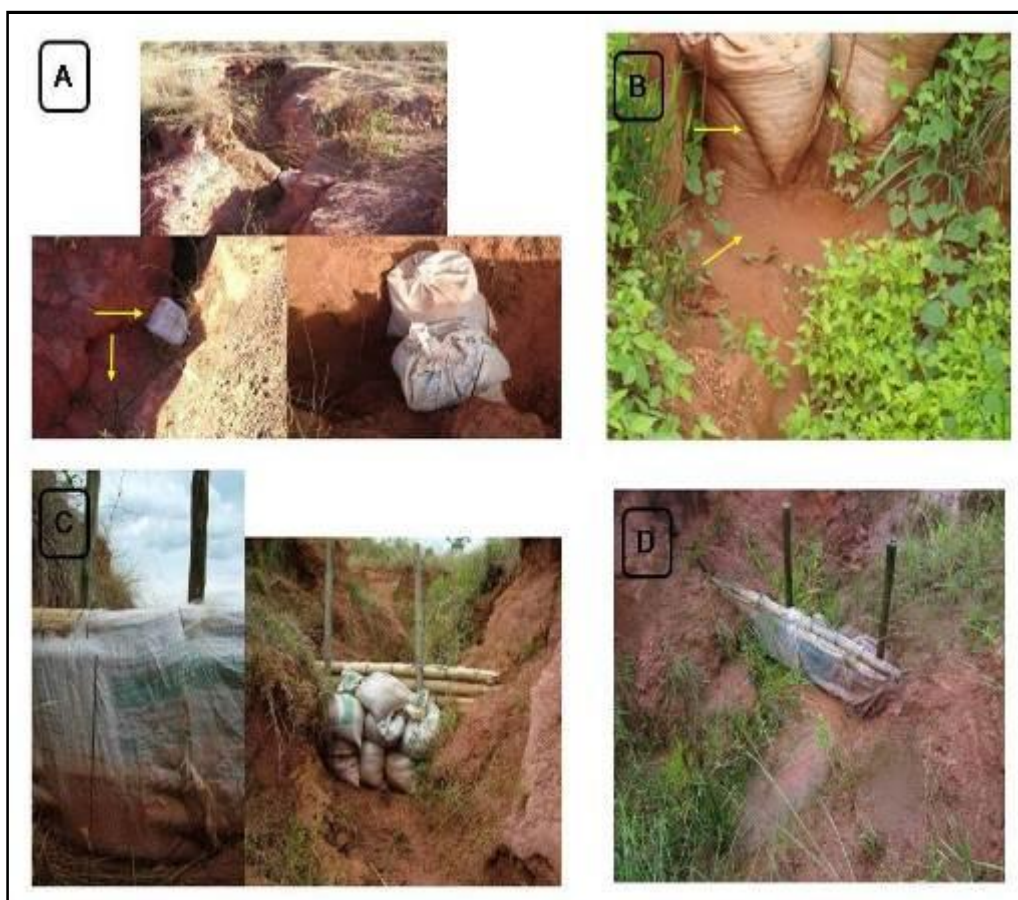
Figura 16 - (A) – (B) – Barramento do excesso de sedimentos (sacos de ráfia). (C) – Paliçada de bambu instalada perpendicular à passagem do fluxo hídrico; (D) – Voçoroca secundária (vizinha) para ilustração da dinâmica do funcionamento da paliçada após ocorrência de chuva próxima aos canais erosivos em estudo.
