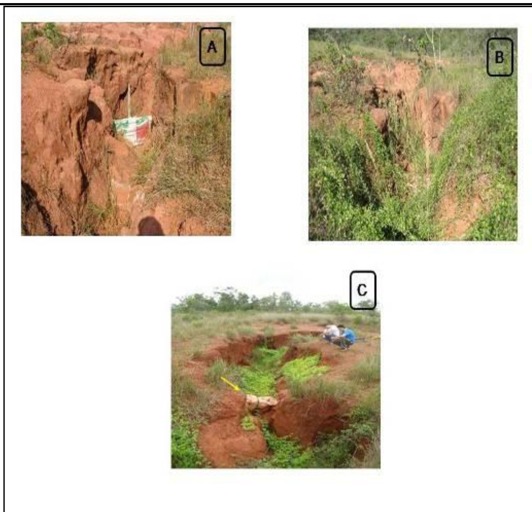
Figura 17 - (A) e (B) – Representação da revegetação proporcionada na área de estudo após instalação da barreira de bambu; (C)–Demonstração da ação conjunta das medidas físicas (barreiras c/ saco de ráfia) e vegetativas.
