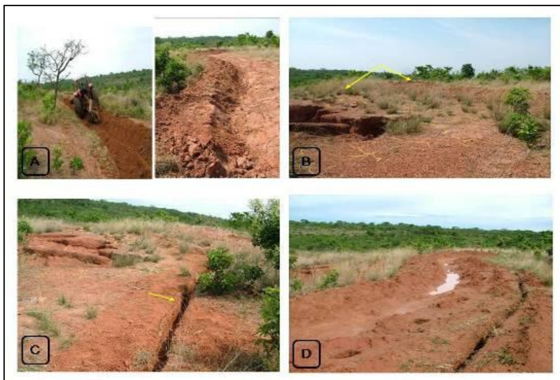
Figura 11 - (A) – Terraço em nível do tipo base estreita: implantado em outubro de 2008; (B) - Vista parcial da localização do terraço à montante dos canais erosivos; (C) - Localização de um dos mulching em relação às incisões erosivas; (D) Demonstração da atividade do terraço acumulando excesso hídrico após ocorrência de chuva.
