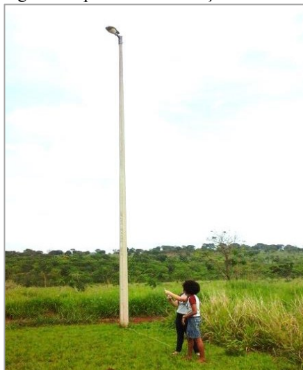
Figura 11: poste de iluminação da escola.
