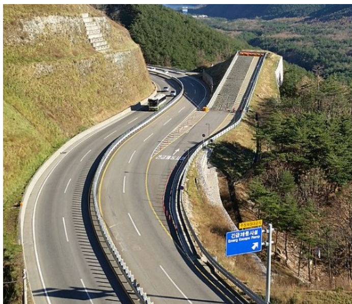
Figura 4 – Rampa de escape.
