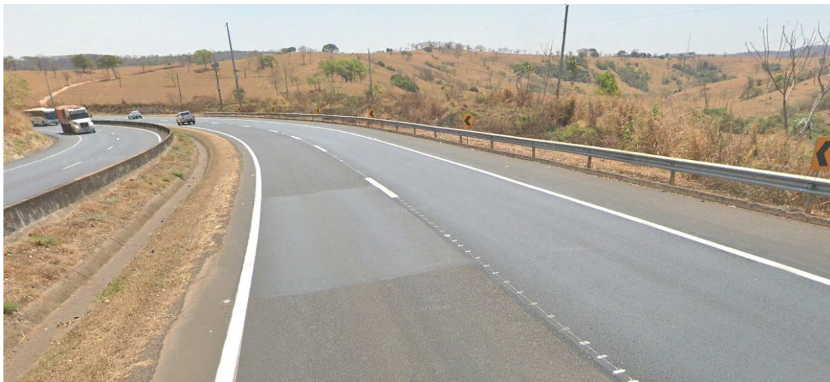
Figura 24 - Curva horizontal km 56+180.
