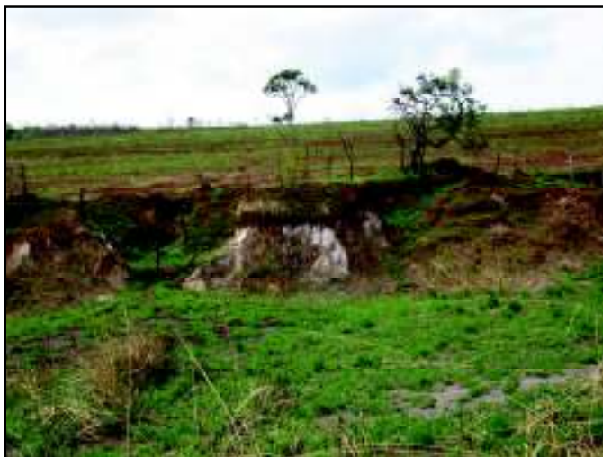
Figura 26: Processo erosivo em área de Cobertura Detrito-Laterítica, a sudeste da bacia. Autor: FLORÊNCIO, B.A.B., 18/08/2009.
