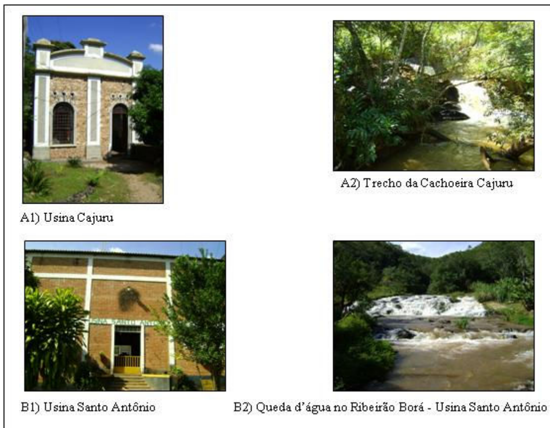
Figura 38: Pequenas Centrais Hidrelétricas da BHRB
