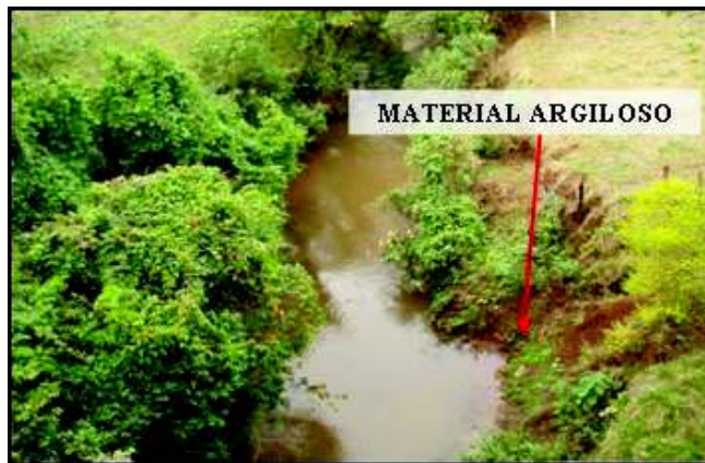
Figura 28: Material argiloso em área de várzea do Ribeirão Borá. Autor: FLORENCIO, B.A.B., 18/08/2009.
