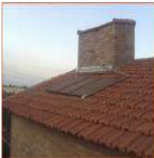
(a) volume do reservatório de 200 L.
