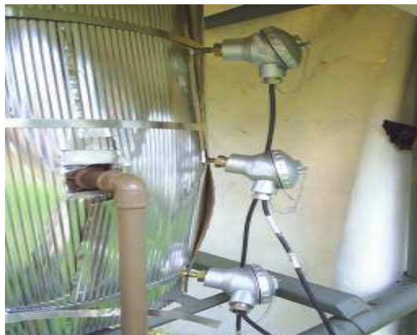
(b) Termopares instalados no reservatório alternativo.
