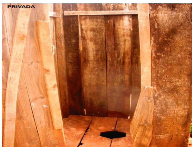
Figura 1 - Instalações sanitárias (Privada)
