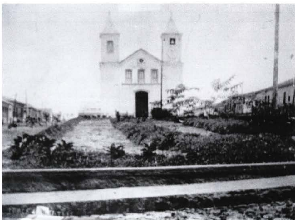
Antiga Igreja matriz Nossa Senhora do Carmo – localizava-se na Praça Cícero Macedo - Acervo do Arquivo Público Municipal de Uberlândia.
