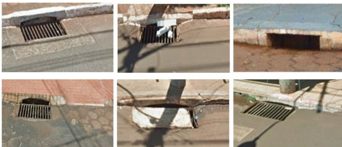
Figura 11 - Tipos das bocas de lobo existentes em Centralina
