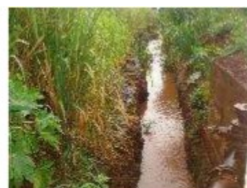
Jusante do bueiro 1
