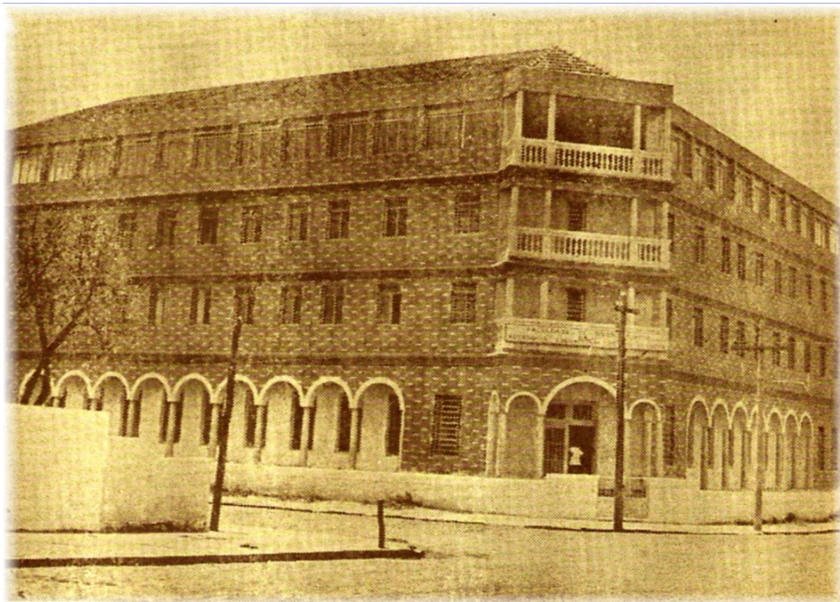
FIGURA 1. Foto da fachada do prédio situado à Avenida Engenheiro Diniz, nº. 1178, antiga Policlínica da Odontologia e atual reitoria da Universidade Federal de Uberlândia, copiada do Jornal “Correio de Uberlândia” de 10 de outubro de 1975, nº. 12.545, ilustrando a reportagem intitulada: Reconhecida pelo Presidente Geisel a Faculdade de Odontologia da Universidade de Uberlândia.
