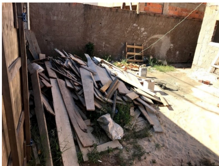
Figura 21 Entulho de forma precária de madeiras retiradas da obra
