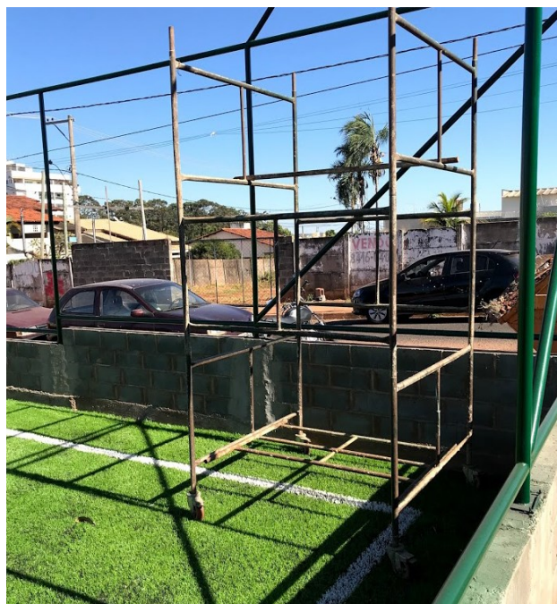
Figura 17 Andaime móvel com rodas e travas
