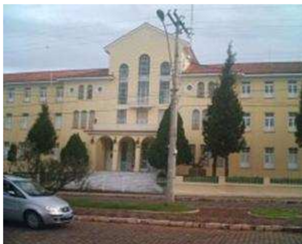
Antigo Palácio Episcopal, construído pelo arquiteto José Rosato em 1902. Em 1929, foi destinado ao Seminário Diocesano e hoje abriga a Cúria Metropolinata.
