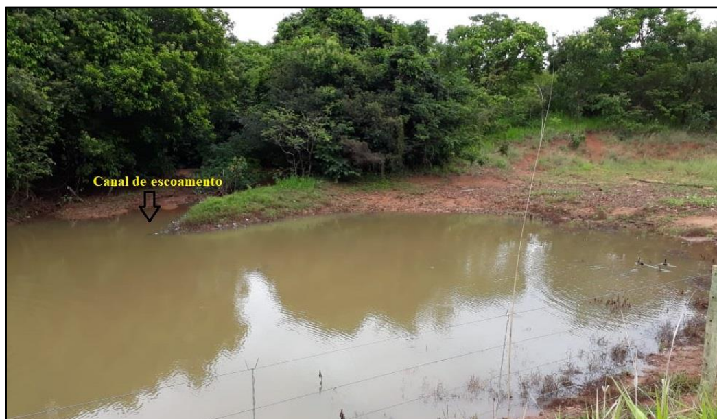
Figura 48: Canal de escoamento com superfície alagada nas proximidades da estrada de acesso ao residual
