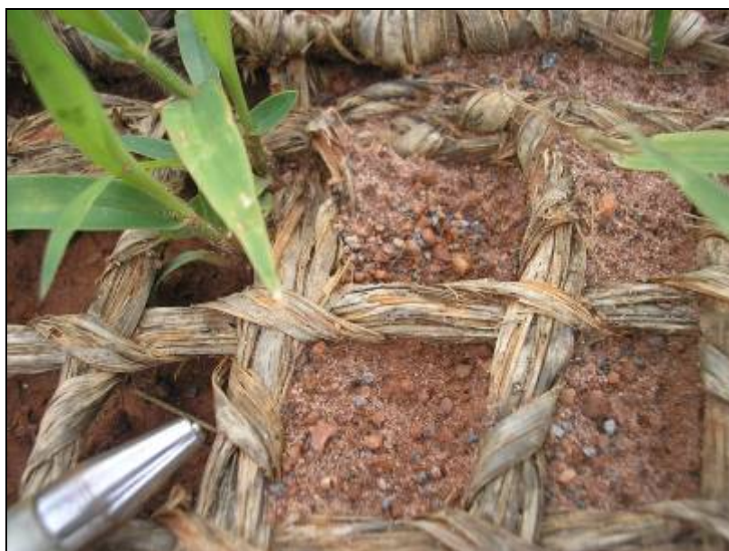
Fig. 62 – Retenção de sedimentos mais grosseiros nos geotêxteis. Autoria: BEZERRA, J.F.R, 24.11.2005.
