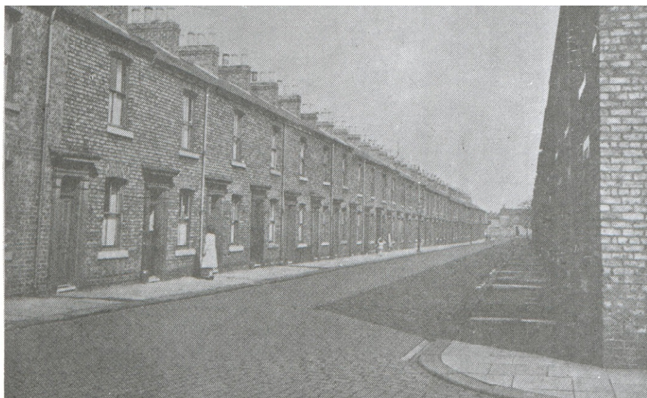
Foto 13 – Bairro periférico inglês, segundo regulamentos de 1875.
