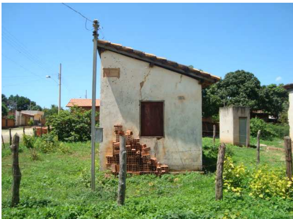
Fotografia 20: Casa construída pela paróquia São José no bairro Sagrada Família no estilo “meia água”. São Francisco-MG, 2008. Fotografia e acervo pessoal do autor.
