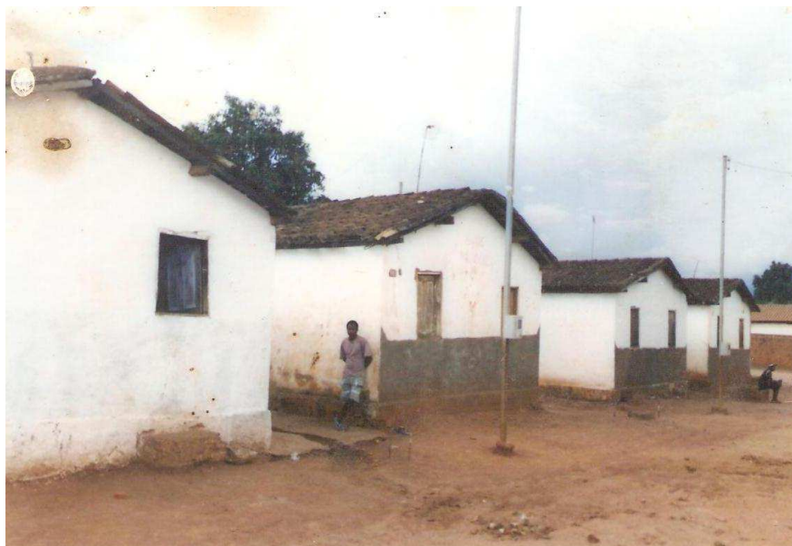
Fotografia 10: Casas contíguas construídas pela paróquia São José no bairro Sagrada Família. Quarteirão da chamada “Vilinha dos Bibil”. 60 São Francisco-MG, 2008. Fotografia e acervo pessoal do autor.
