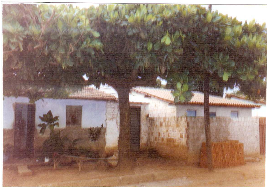
Fotografia 11: Fotografia de casas construídas pela COHAB no bairro Sagrada Família. São Francisco-MG, 2008. Fotografia e acervo pessoal do autor.
