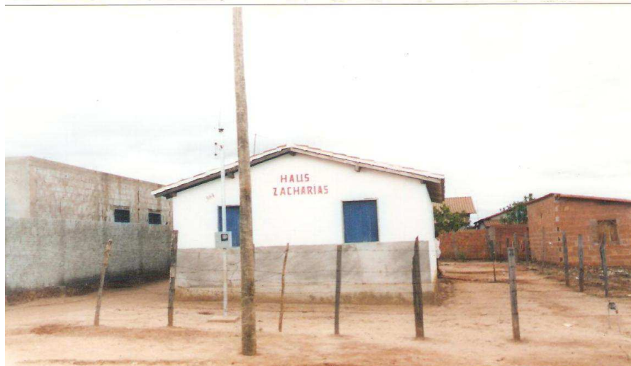
Fotografias 18 e 19: Casas construídas pela paróquia São José no bairro Sagrada Família. São Francisco-MG, 2008. Fotografia e acervo pessoal do autor.
