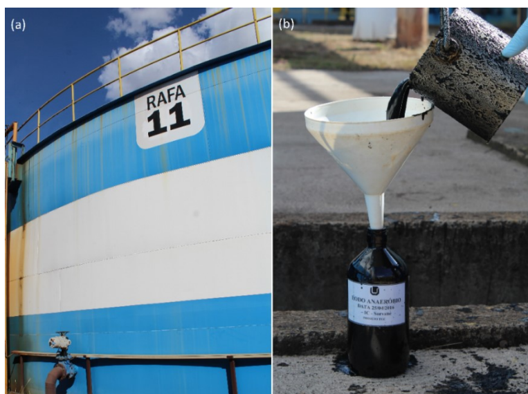
Figura 4 - (a) Reator Anaeróbio de Fluxo Ascendente (RAFA). (b) Frasco âmbar com volume de 1000 mL.
