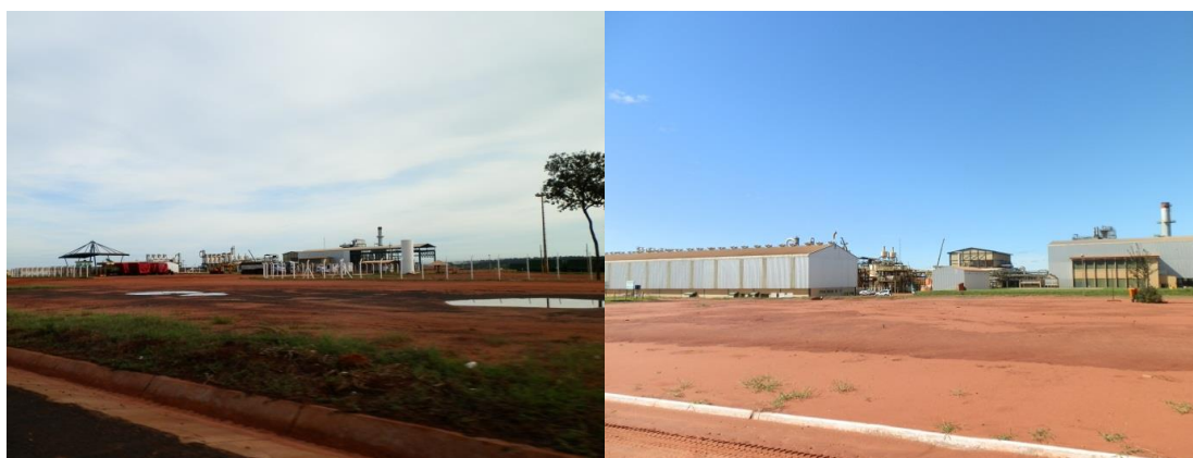
FIGURA 3. Vista parcial do pátio industrial da Usina Vale do São Simão.
