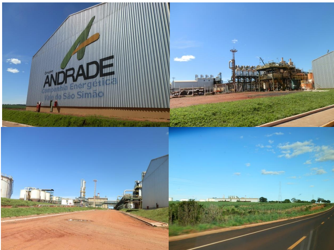
FIGURA 1. Vista parcial do pátio industrial da Usina Vale do São Simão.
