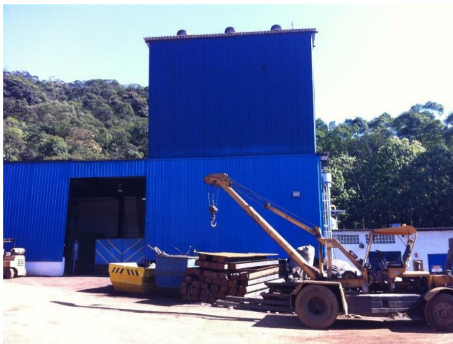
Figura 3.2 – Área externa do reator nas instalações de Mauá-SP
