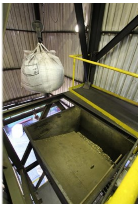
Figura 3.5 – Sistema de alimentação de CDRSU
