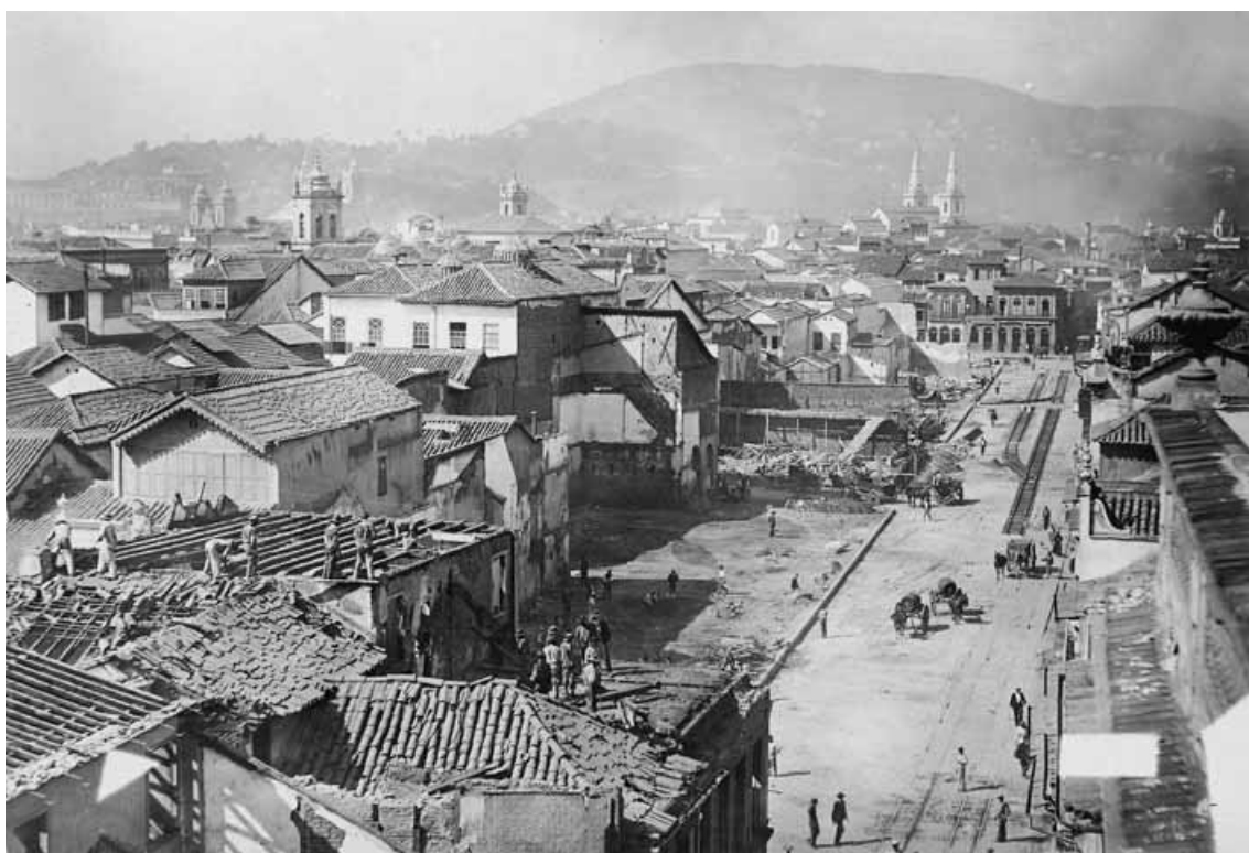
Ilustração 29 - O início dos trabalhos de abertura da Avenida Central. 1904. Fotografia de João Martins Torres. 268
