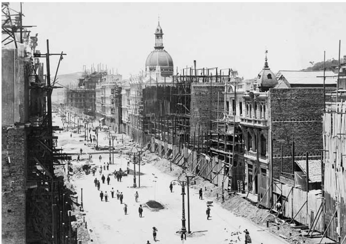
Ilustração 30 - Avenida Central em fase de construção, 1905. Fotografia de João Martins Torres. 269
