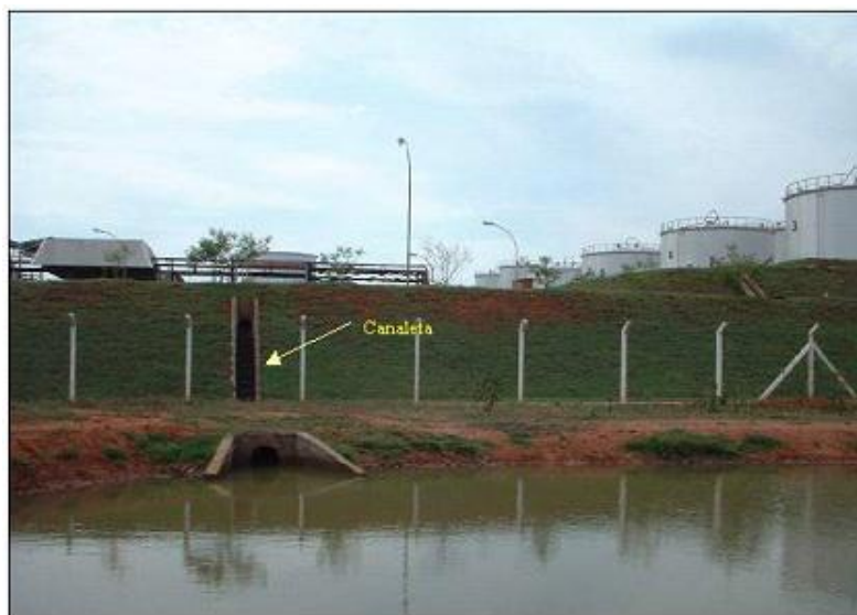
Figura 7 - Lagoa mostrando a canaleta e o bocal de descarga do efluente na mesma.
