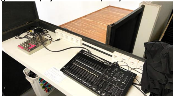
Figura 6: Espaço técnico – operação de luz e som.
