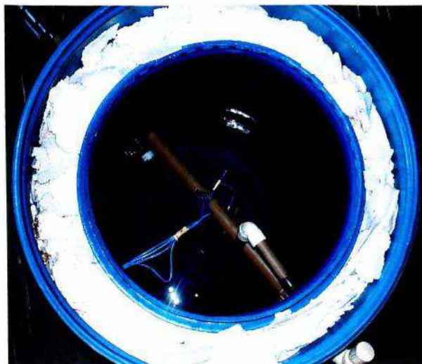
Figura 2.6b – Interior do reservatório
