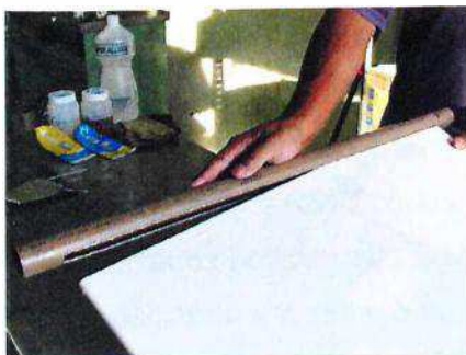
Figura 2.3 - Encaixe do forro
