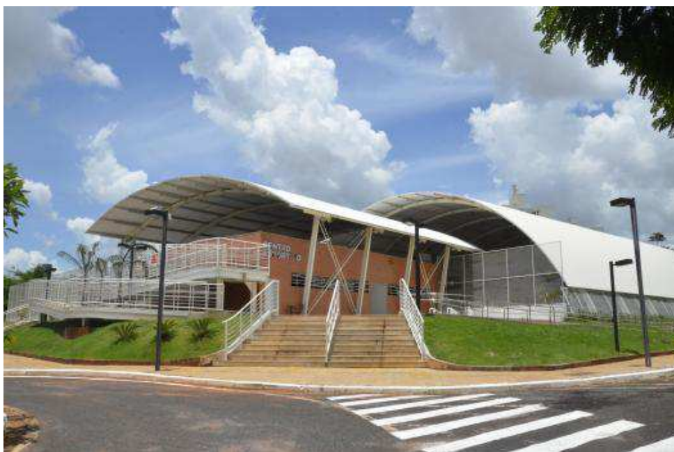
Figura 3 - Centro esportivo da Universidade Federal de Uberlândia
