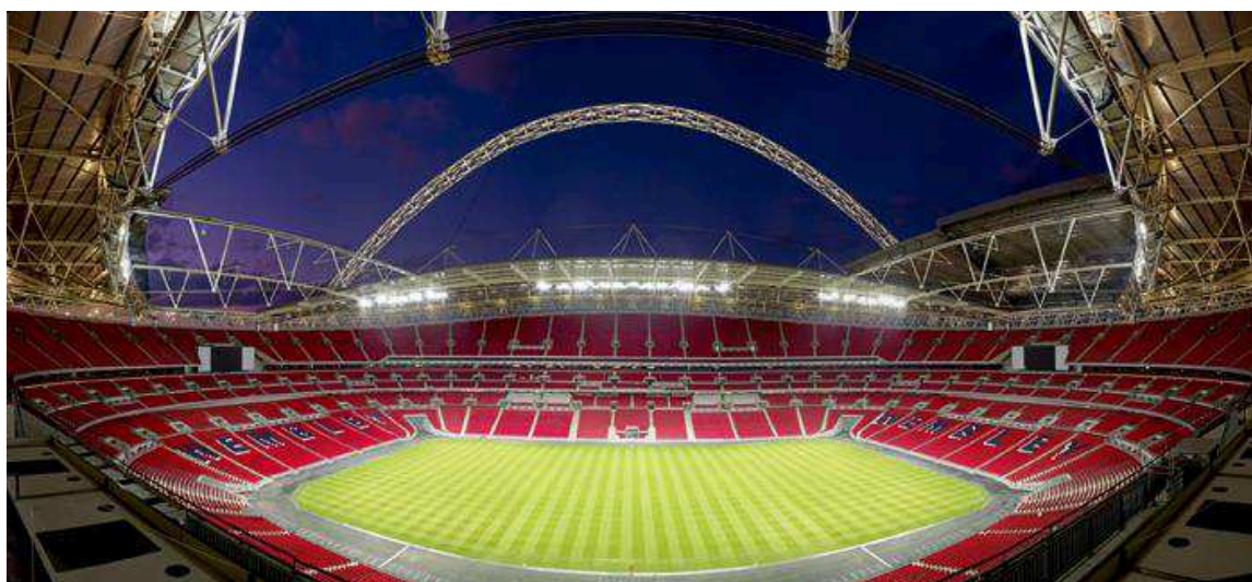
Figura 2 - Estádio de Wembley, na Inglaterra, e detalhe de seu arco principal
