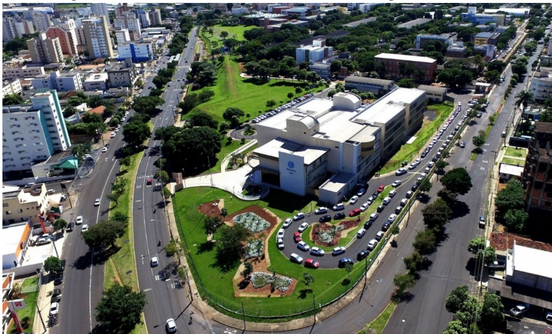
Figura 5: Universidade Federal de Uberlândia – Campus Santa Mônica
