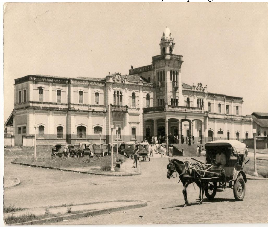
FOTO 5 – Década 40: Estação de passageiros.
