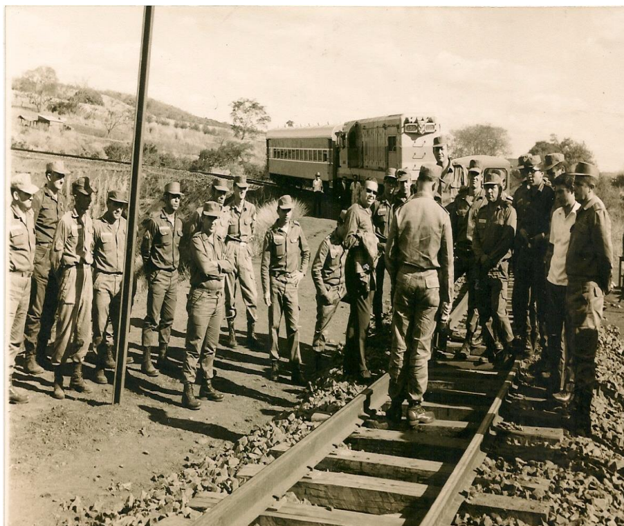
FOTO 8 – Década de 70: Militares do 2º Batalhão Ferroviário, trabalhando em trecho da ferrovia.
