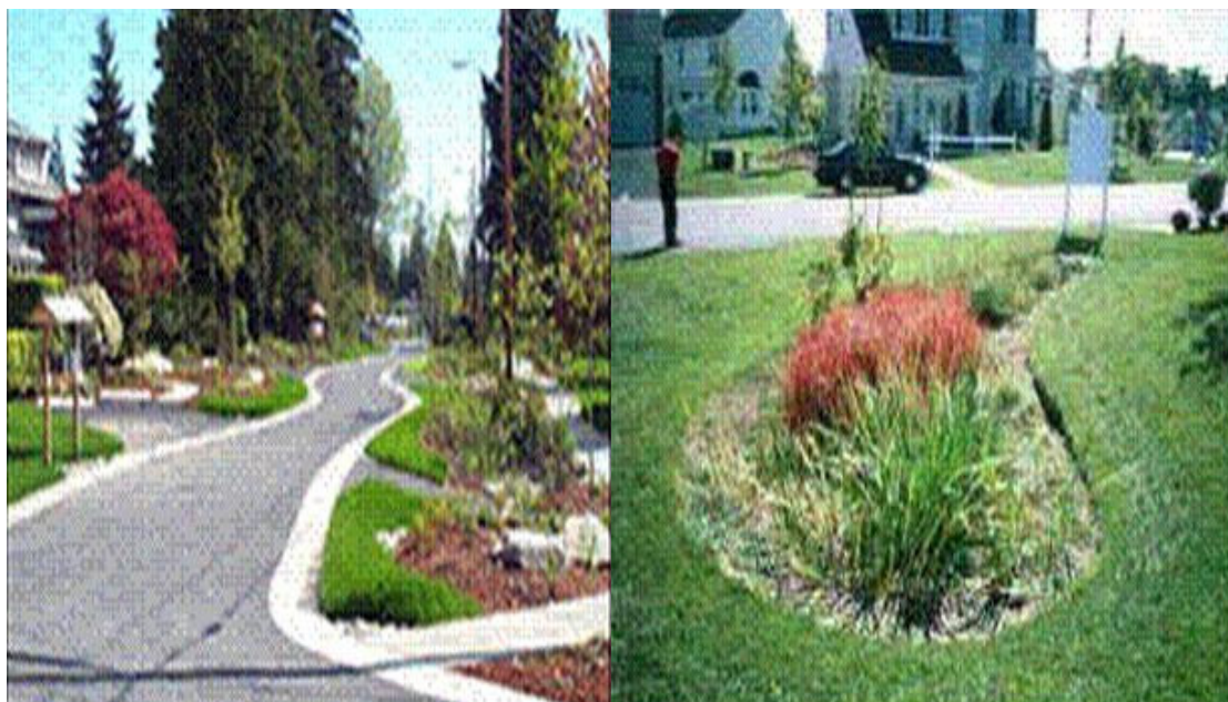
Figura 2.10 - Rua sem meio fio com áreas gramadas para infiltração Fonte: Tucci, 2005, p. 90.
