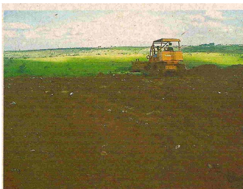
Figura 17: Aterramento de resíduos sólidos no Aterro Controlado de Araguari-MG.
