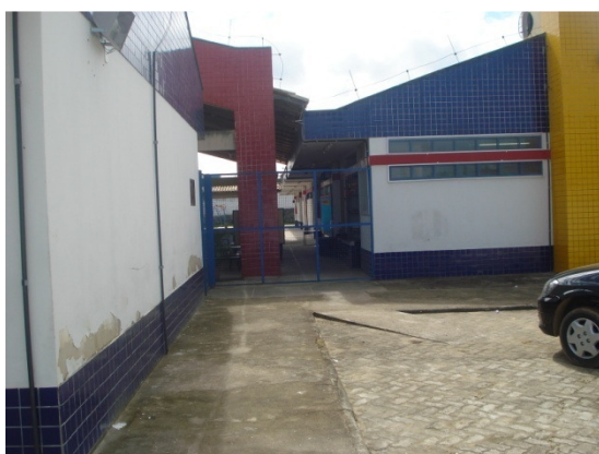
Fotografia 6 - Segundo portão de acesso às dependências do CEMEI.
