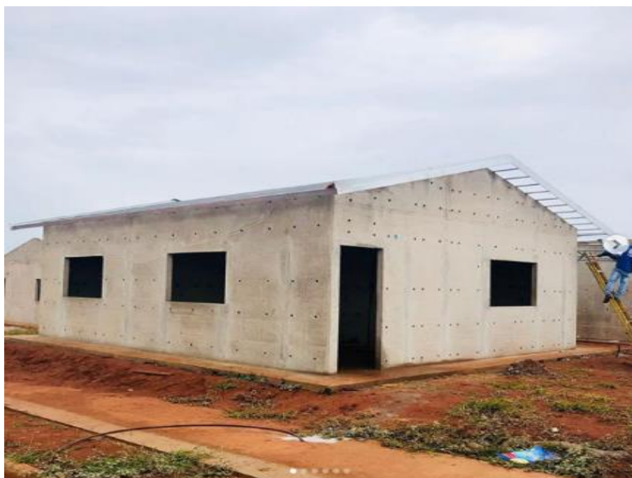
Figura 04 – Desforma e execução da cobertura
