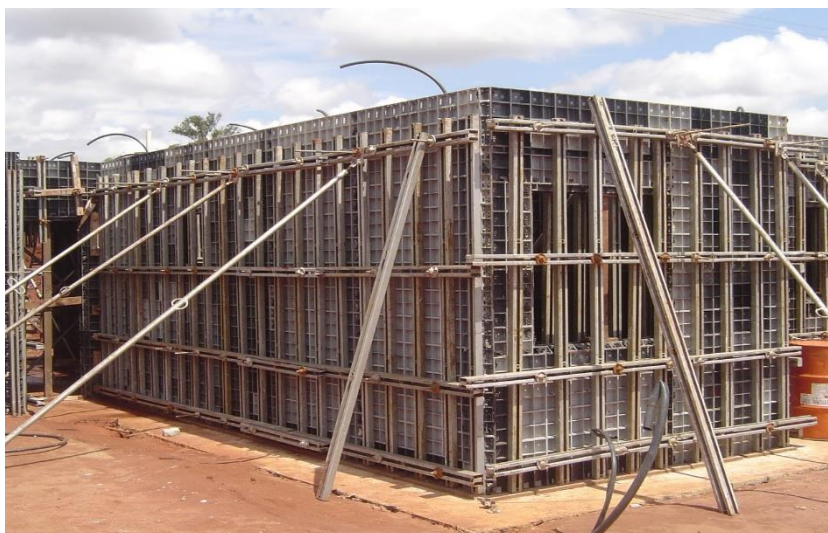
Figura 14 – Fôrma para paredes de concreto do tipo metálica
