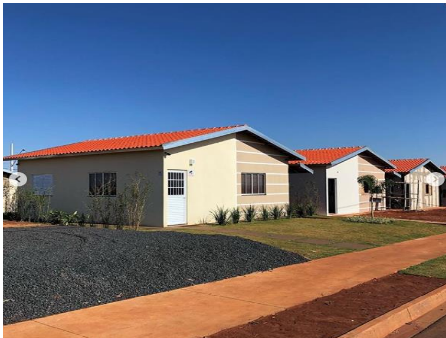
Figura 05 – Execução de acabamento final
