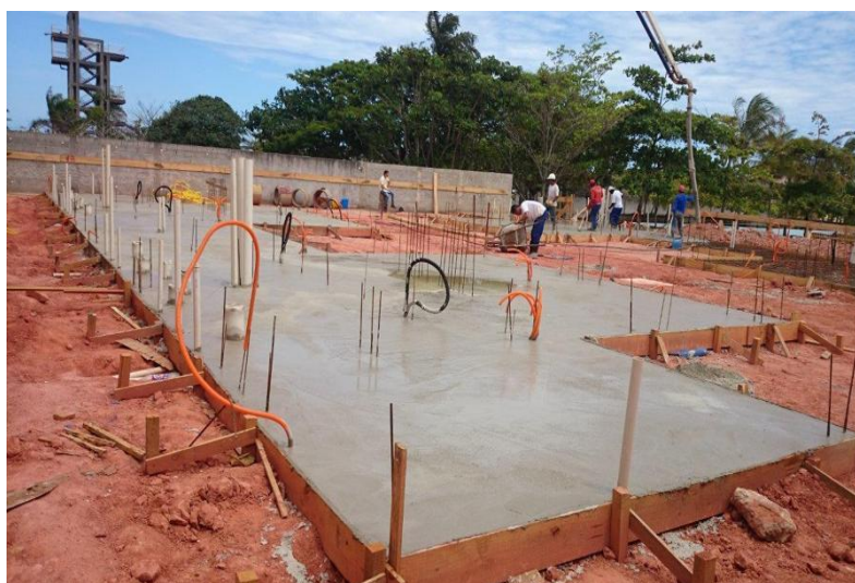
Figura 07 – Fundação tipo Radier
