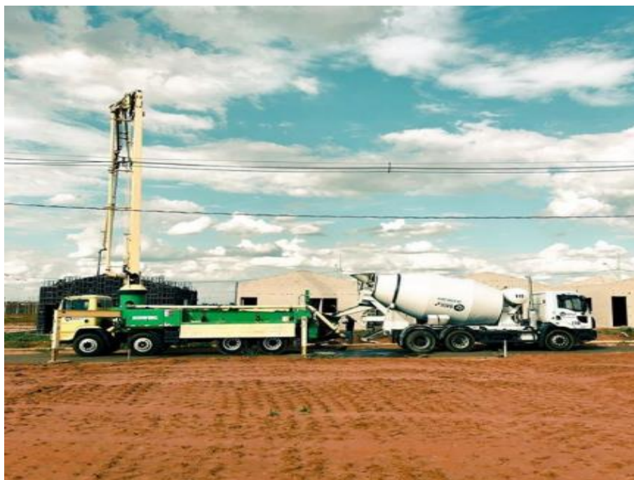
Figura 03 – Concretagem das paredes
