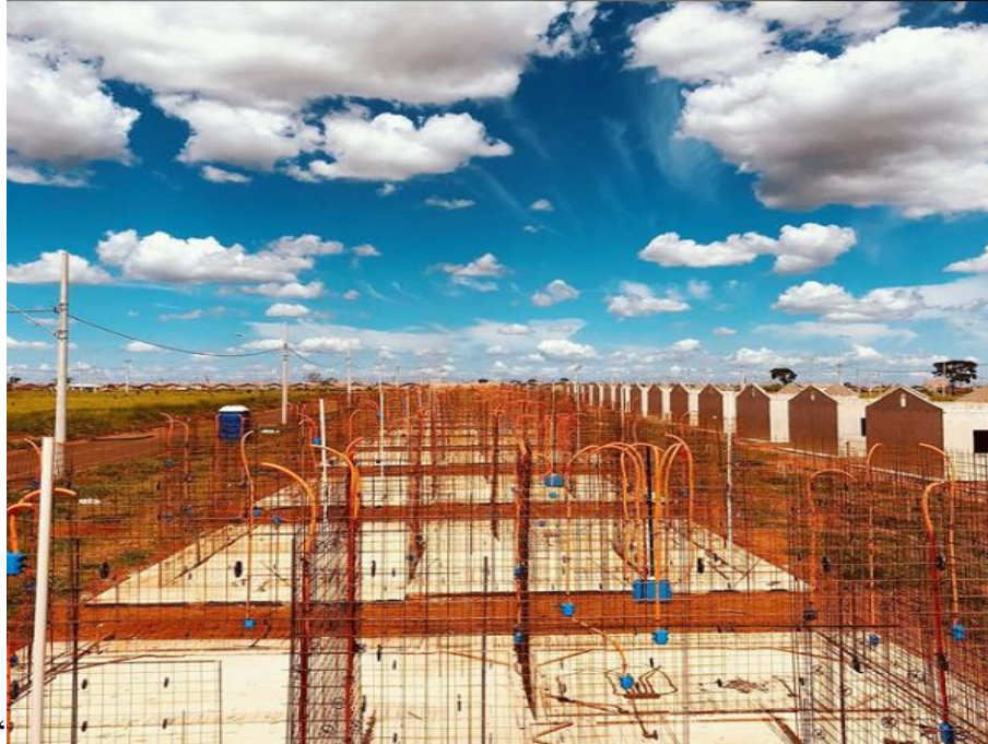
Figura 01 – Montagem da armadura e fixação das instalações sobre radier
