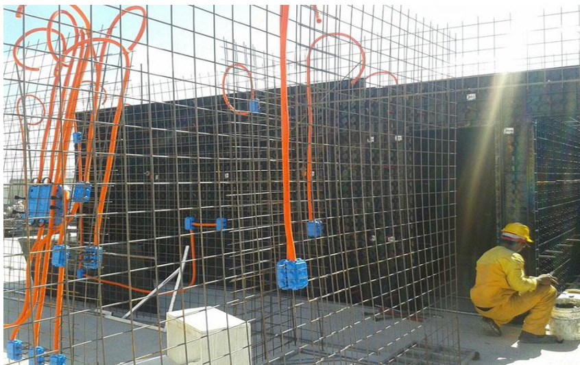
Figura 11 – Montagem e fixação das instalações elétricas
