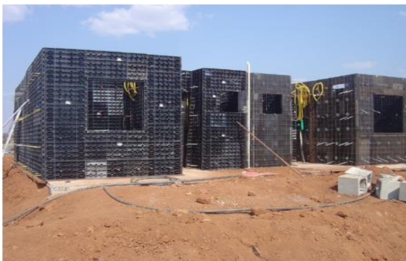
Figura 16 – Fôrma para paredes de concreto do tipo plástica
