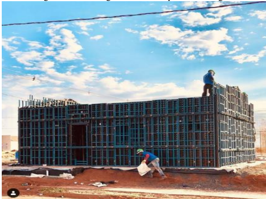
Figura 02 – Montagem das fôrmas para concretagem
