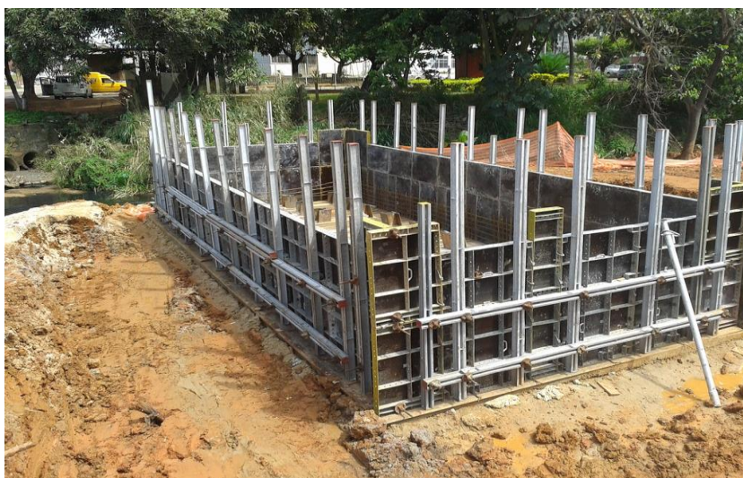
Figura 15 – Fôrma para paredes de concreto do tipo mista (metálica com chapas de compensado)
