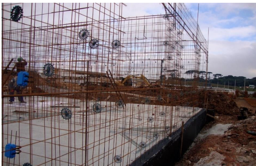
Figura 10 – Montagem da armadura
