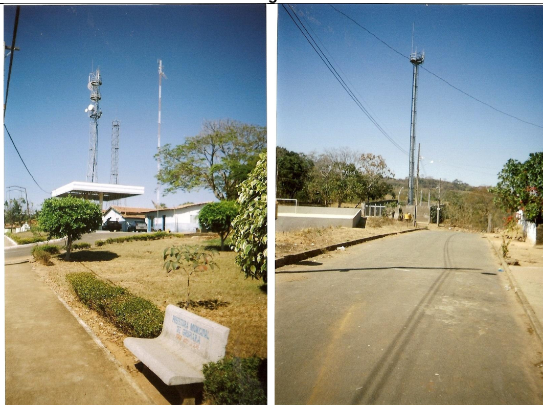
Antenas de Celular da cidade de Grupiara (esquerda) e de Estrela do Sul (direita) e de Cascalho Rico (abaixo).
