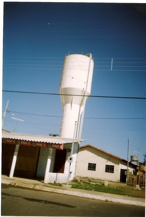
Poço Artesiano da cidade de Grupiara – MG.
