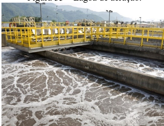
Figura 35 – Lagoa de aeração.
