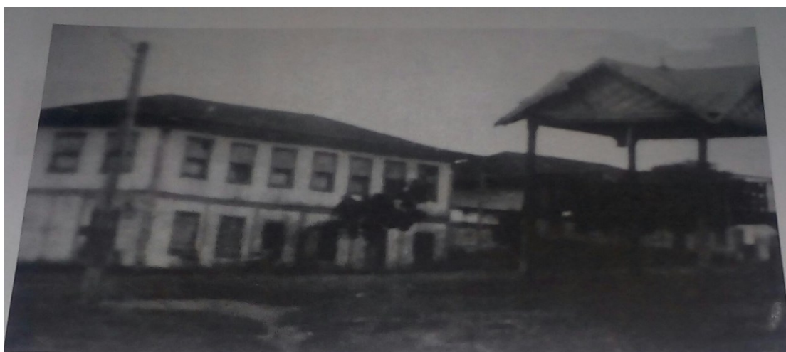
Década de 1920 - Praça da Matriz – imóvel que sediou a Câmara, Cadeia e Fórum de Araguari. Foto: Antônio Gebhardt.
