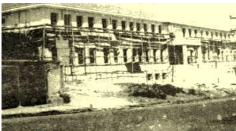
Foto 6 - Construção do Colégio Imaculada Conceição, [195-]
