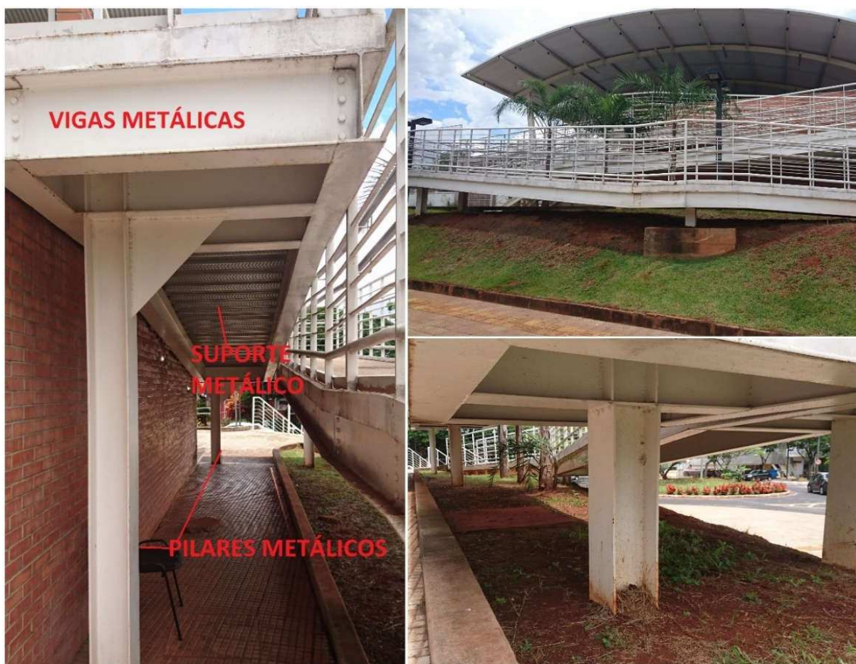
Figura 44 - Rampa que liga o pavimento térreo à academia executada em estrutura metálica
