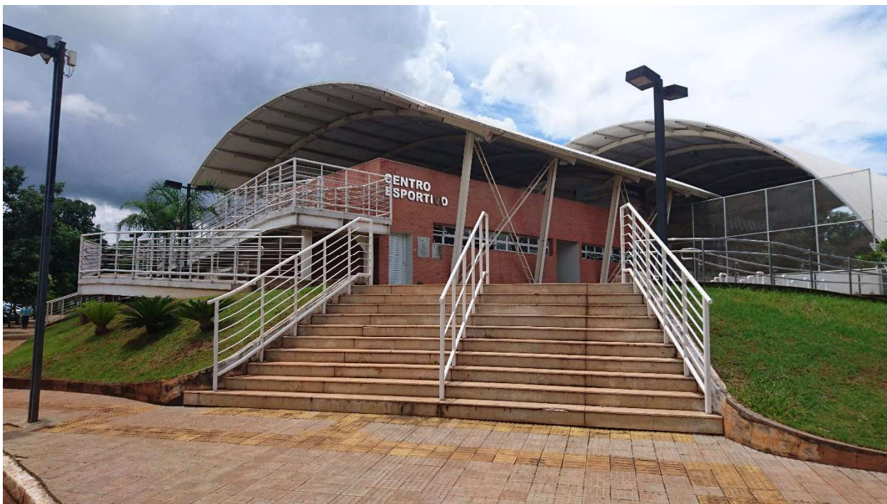
Figura 38 - Escada 1 executada com corrimão intermediário
