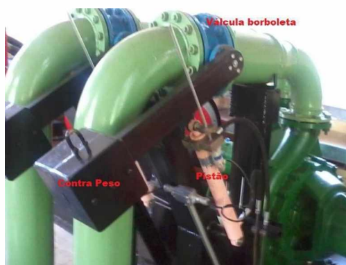
Figura 33 Acionamento da válvula borboleta.
