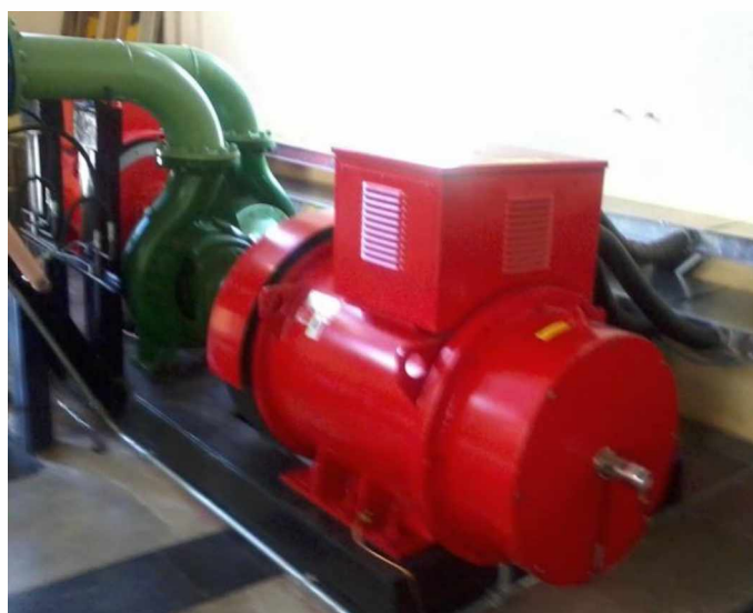
Figura 29 Vista da instalação do segundo experimento
