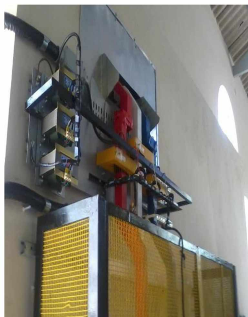
Figura 36 TC e TP de Medição
