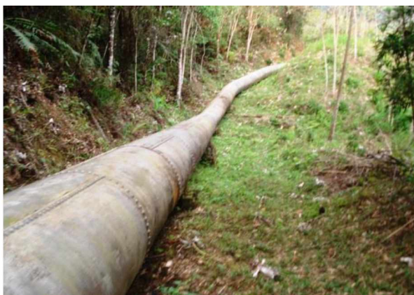
Figura 21 Trecho do conduto foçado.
