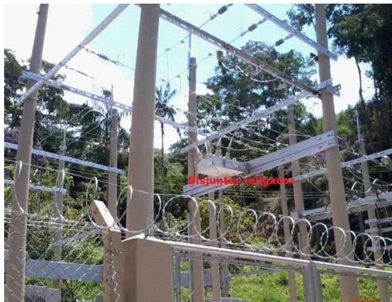
Figura 38 Disjuntor religador.
