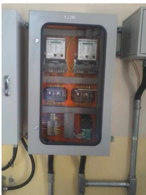
Figura 35 Medição de energia
