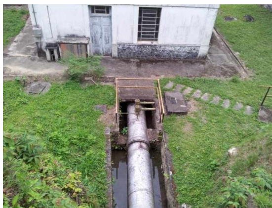
Figura 20 Entrada do Conduto Forçado
