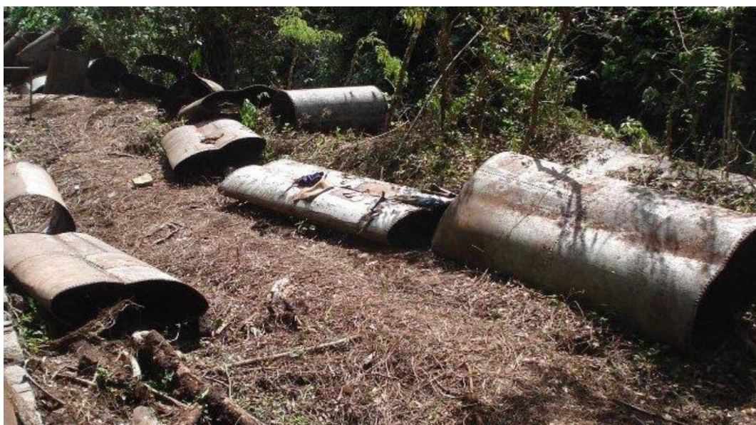
Figura 22 Conduto danificado.
