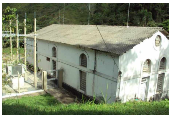
Figura 13 Usina onde foram instalados os protótipos Fonte: Foto do autor
