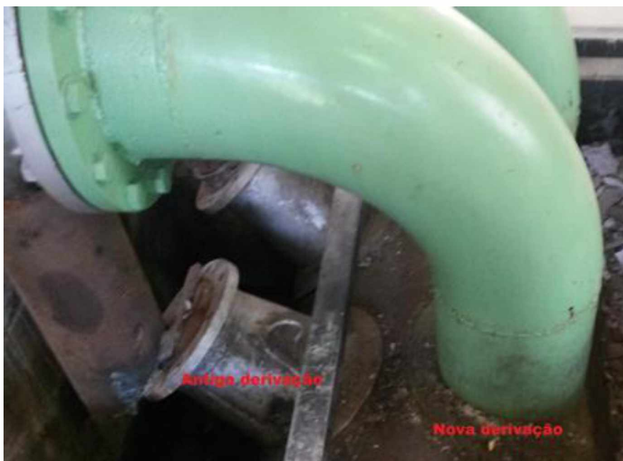
Figura 49 Nova derivação do duto.
