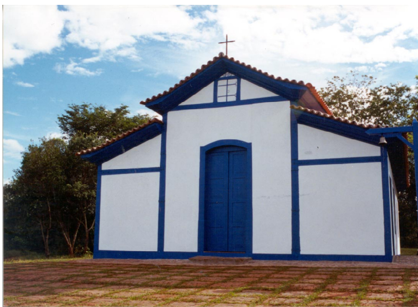
Figura 2 - Distrito de Miraporanga: igreja de Nossa Senhora do Rosário, 2001.
