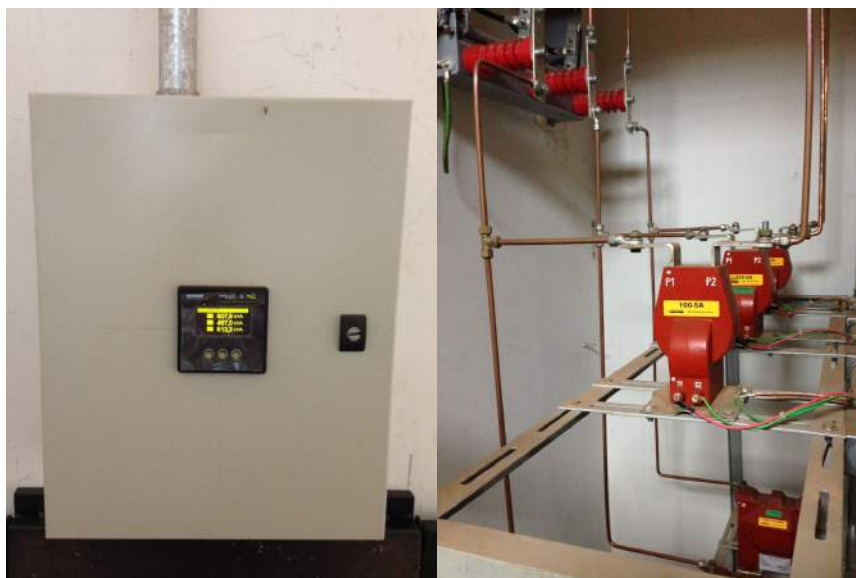
Figura 2.3 – Foto do medidor de qualidade da energia e do cubículo de medição para estudo na cabine de entrada do Campus Santa Mônica da UFU.
