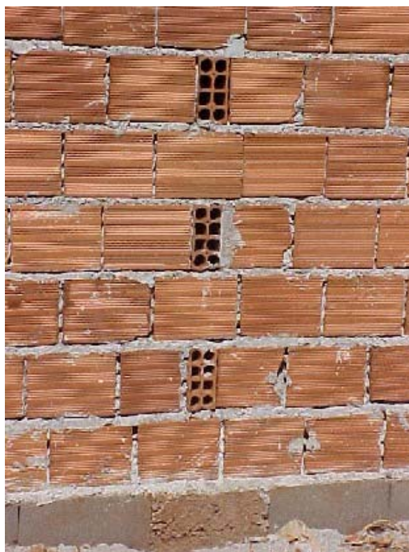
Figura 4.13 – Nas fiadas de baixo juntas de amarração fora do centro do bloco.
