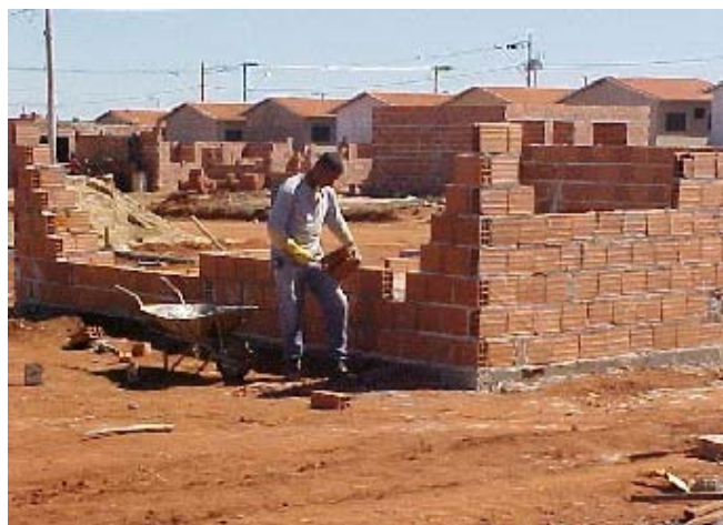
Figura 4.15 – Construtor quebrando o bloco para fazer a amarração.
