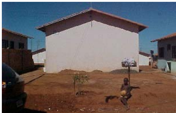
Figura 6.11 – Casa terminada com muro iniciado e parte do material para execução.
