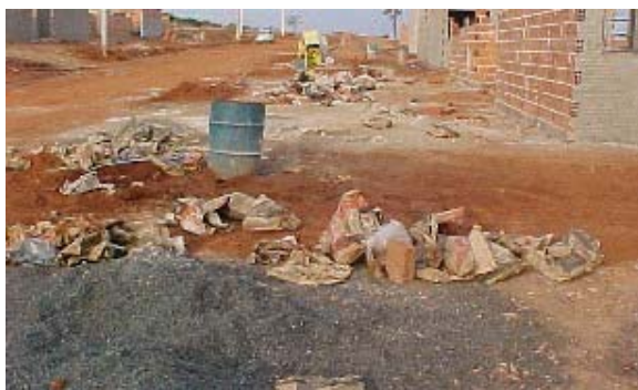
Figura 3.18 – Local próximo à betoneira onde ficavam os montes de areia e brita.
