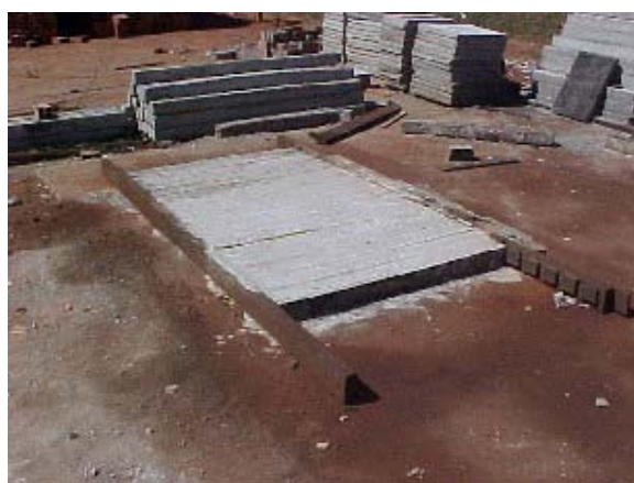
Figura 3.10 – Vergas em fabricação.
