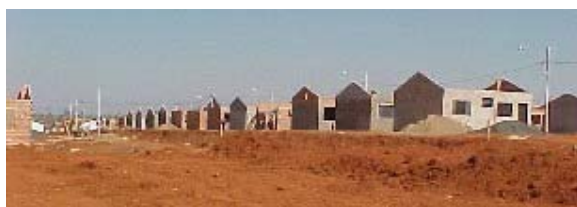
Figura 3.5 – Vista externa da obra.
