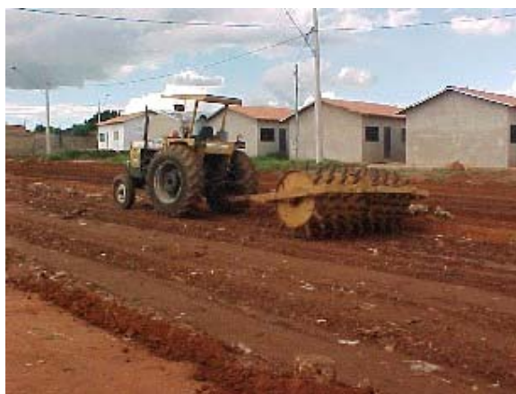
Figura 2.16 – Trabalho em conclusão.
