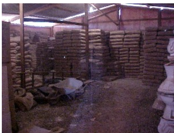
Figura 3.15 – Estoque de cal e cimento.
