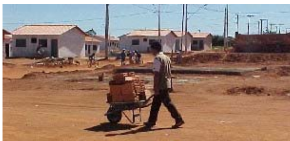
Figura 4.4 – Transporte dos blocos com carrinho-de-mão.
