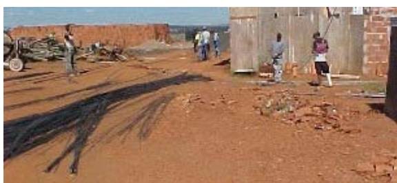
Figura 3.7 – Central de armação.
