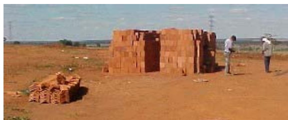
Figura 3.17 – Estoque de telhas e blocos
