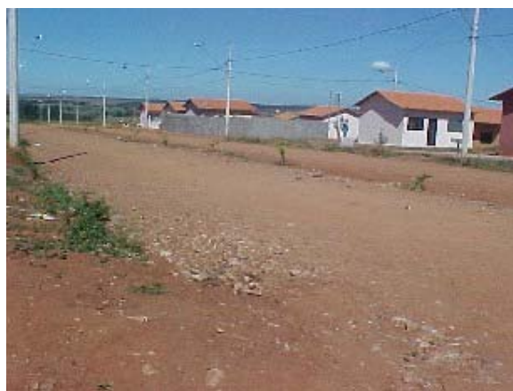
Figura 6.10 – Via pavimentada com o resíduo, 4 meses depois.
