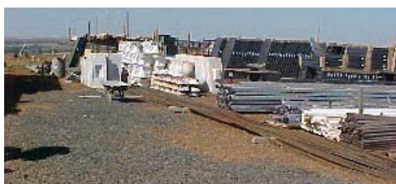
Figura 3.12 – Pátio descoberto do almoxarifado.
