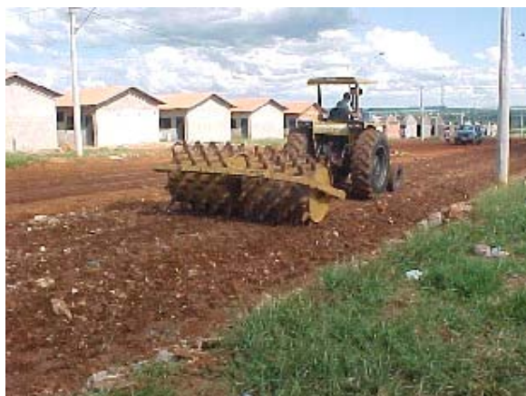
Figura 6.7 – Distribuição e compactação do entulho na via.
