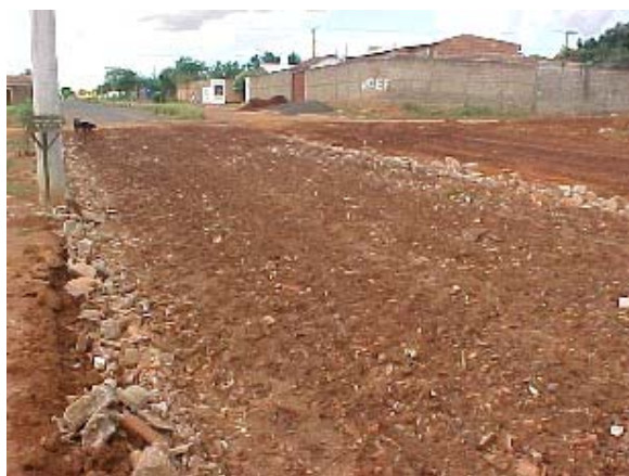
Figura 6.9 – Via pavimentada com o resíduo da construção.
