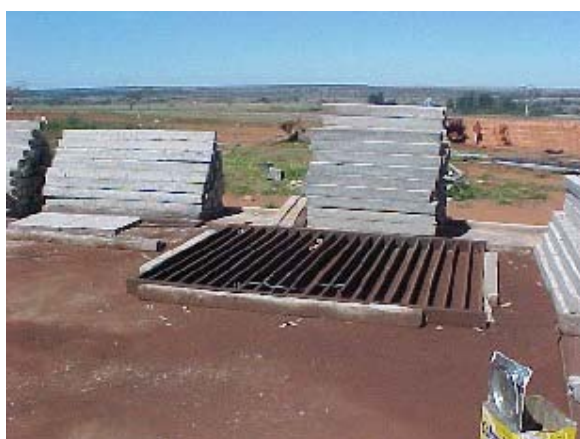
Figura 3.9 – Fôrma e estoque de vergas.
