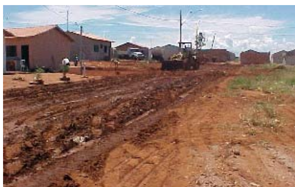
Figura 6.5 – Via sendo preparada.
