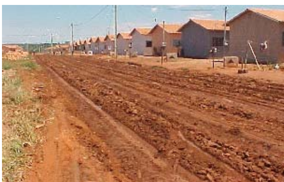
Figura 6.6 – Via após preparação.
