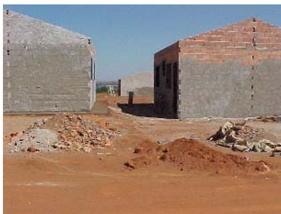
Figura 3.21 – Casas com seus montes de entulho e monte de terra para reaterro de instalação de esgoto.
