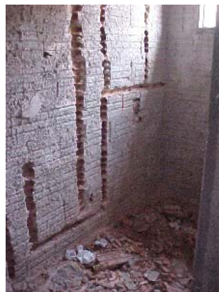
Figura 4.23 – Cortes para instalações hidráulicas.
