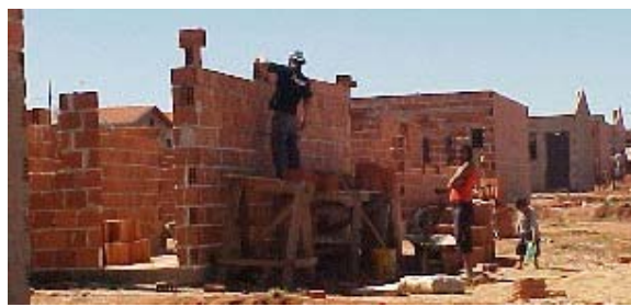
Figura 4.5 – Cavaletes e plataformas para andaimes.
