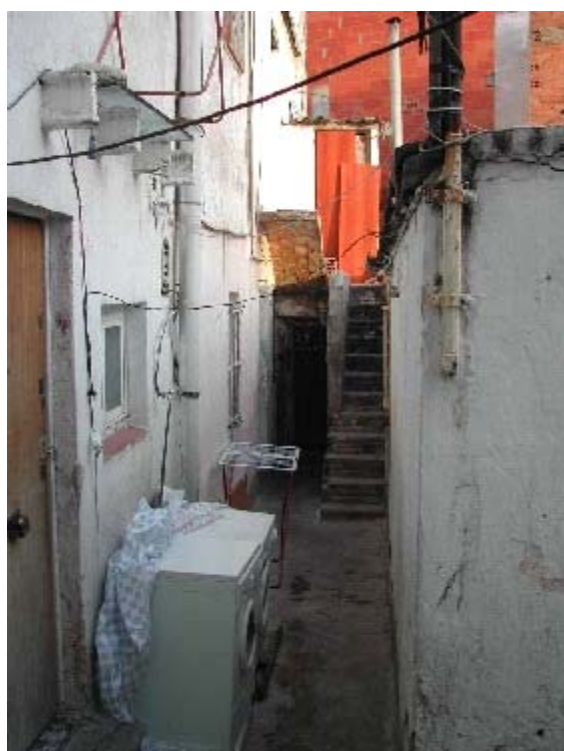
Figura 2.2 – Pátio interno de moradia de qualidade inferior .
