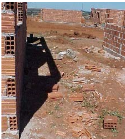
Figura 4.14 – Parede desaprumada.
