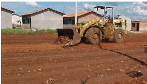
Figura 6.3 – Maquinário raspando a parte desagregada da via.
