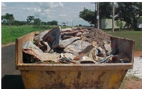
Figura 2.17 – Caçamba de entulho com sacos de cimento e lixo misturado.
