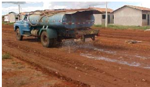
Figura 6.4 – Via sendo umedecida.
