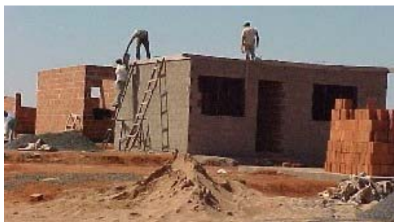
Figura 4.9 – Transporte das latas de concreto até a laje.
