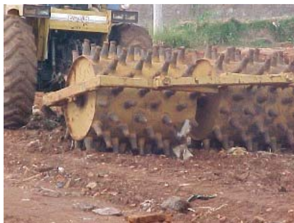
Figura 6.8 – Compactação do entulho na via.
