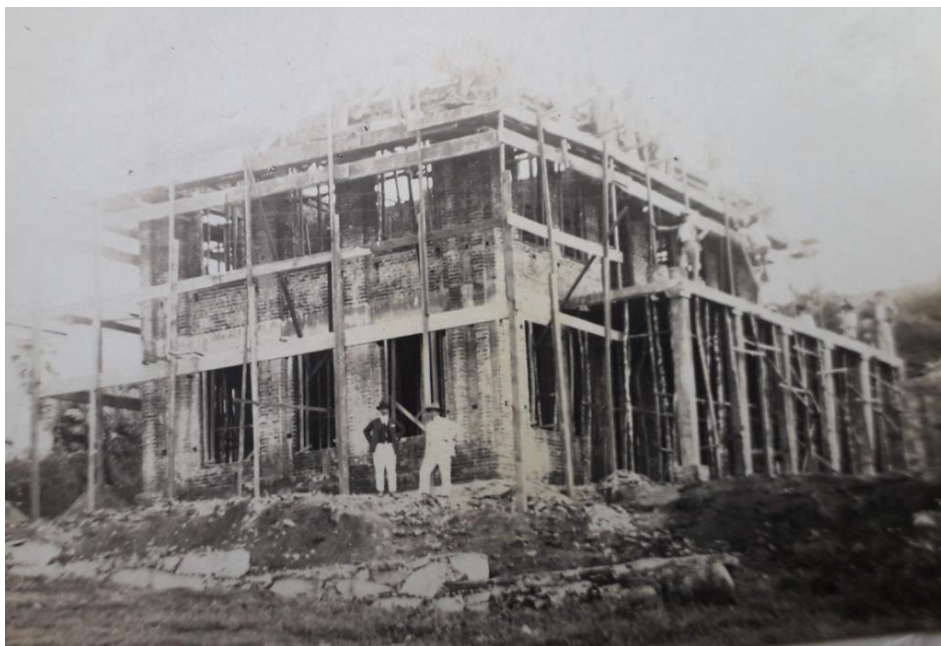
Figura 5 – Esqueleto de concreto do primeiro pavilhão. Fonte: Dossiê Prefeitura.
