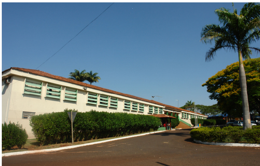
Figura 4: Vista lateral do prédio central da Escola Agrotécnica Federal de Uberlândia
