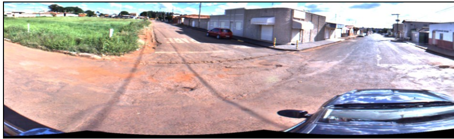
Figura 32 - Imagens Panorâmicas – visualização da condição de asfaltamento.
