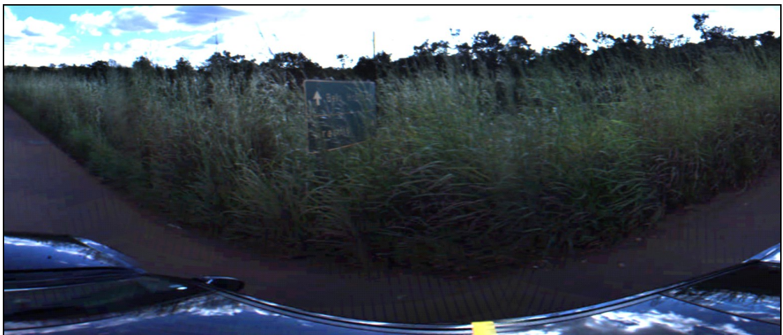
Figura 35 - Imagens Panorâmicas – visualização da condição de asfaltamento e sinalização vertical.
