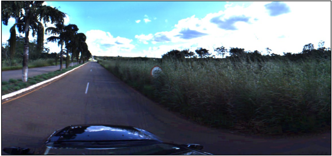
Figura 34 - Imagens Panorâmicas – visualização da condição de asfaltamento e sinalização vertical.
