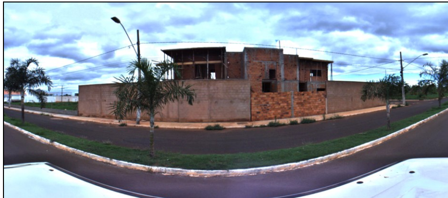
Figura 30 - Imagens Panorâmicas – visualização de fachadas residenciais em construção.
