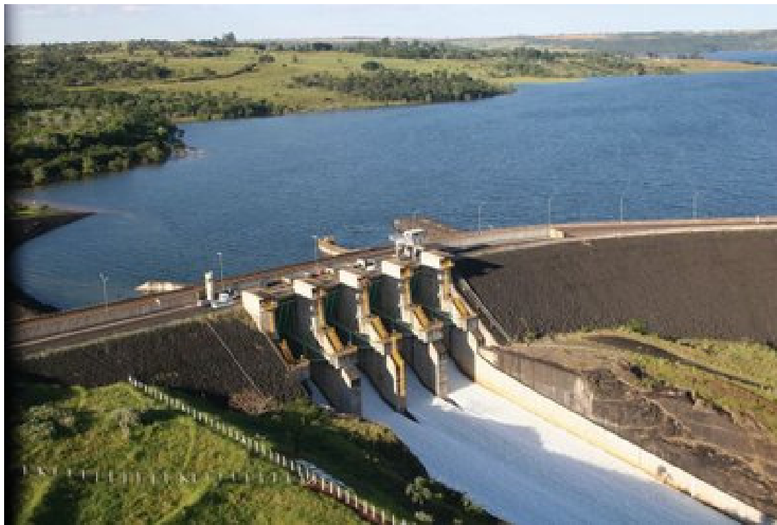
Figura 6 – Usina hidrelétrica Amador Aguiar I. Fonte: CCBE (2009).
