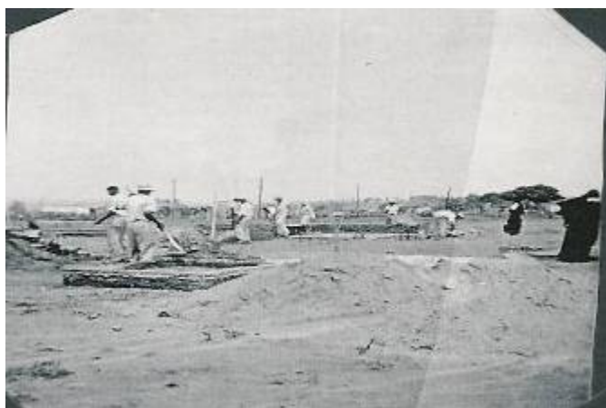
Figura 22 – Operários trabalhando na fundação da escola
