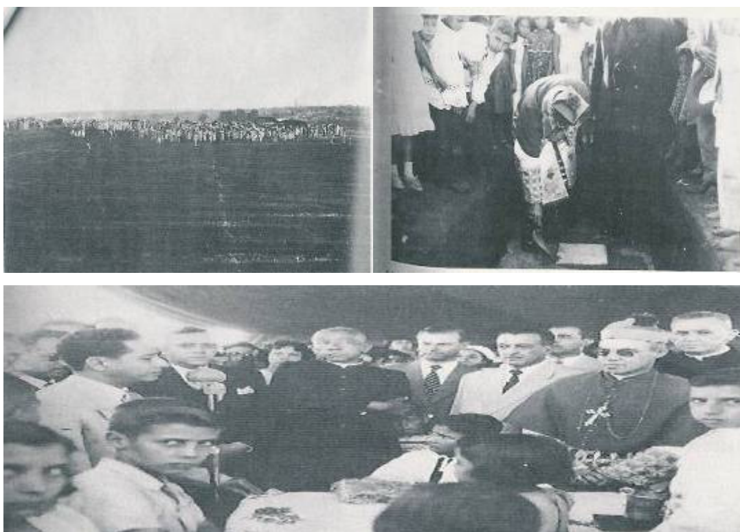
Figura 4 - Lançamento basilar da construção da nova sede do Ginásio Cristo Rei (no atual Bairro Sta. Mônica)
