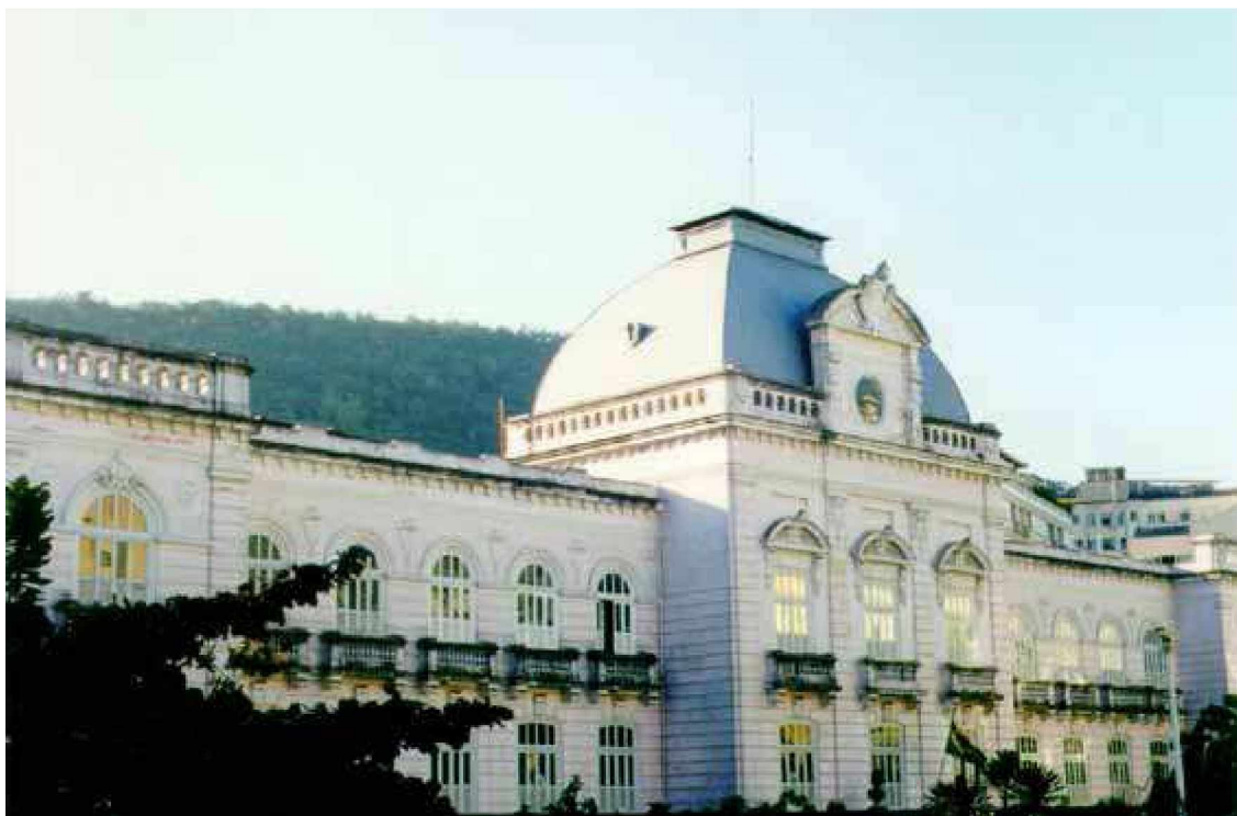
Imagem 494 – Instituto Nacional de Educação de Surdos – INES (Rio de Janeiro/RJ). O arquiteto francês Gustav Lully projetou e construiu o prédio de estilo neoclássico onde, desde 1915, funciona o INES.
