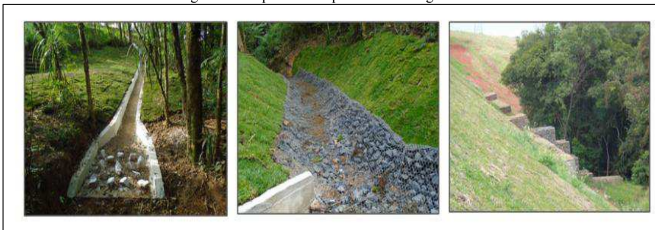
Figura 32 - Tipos de dissipadores de energia
