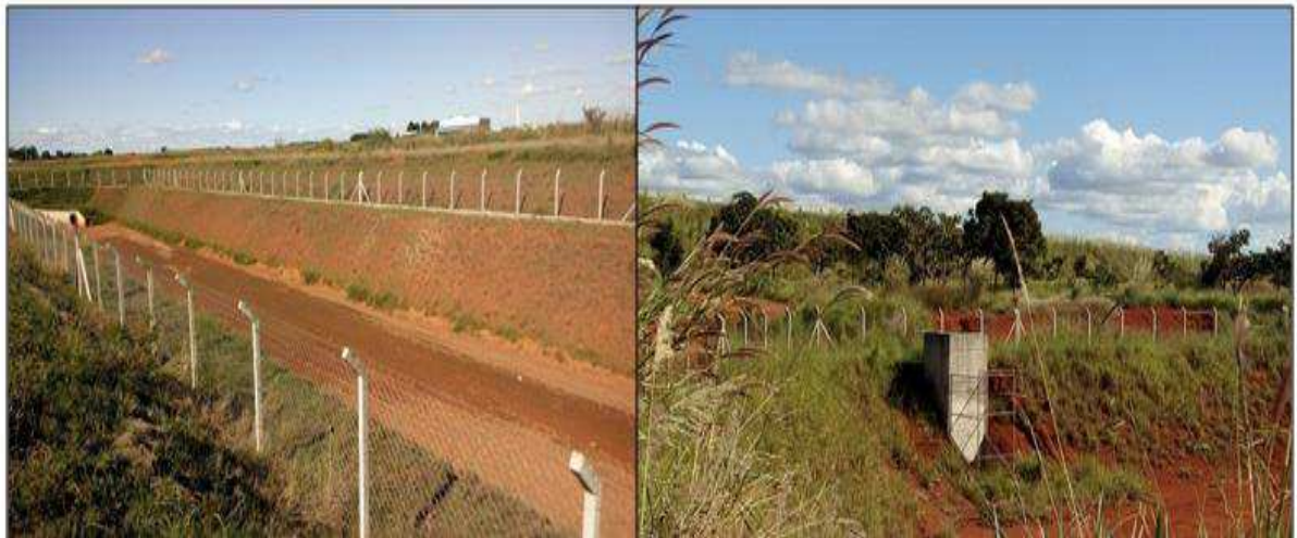
Figura 41 - Reservatórios de retenção em loteamento no Bairro Novo Mundo (Uberlândia/MG)
