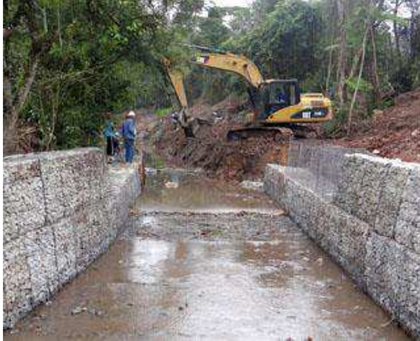
Figura 30- Gabiões caixas sendo colocados no Córrego Taiaçupeba-Mirim, em Ouro Fino (SP)
