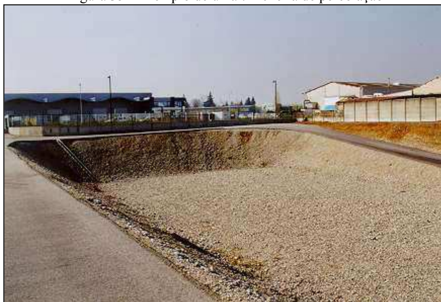
Figura 35 - Exemplo de uma trincheira de percolação
