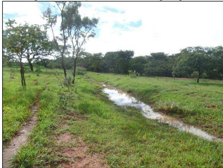
Figura 26 - Terraços em nível no Córrego Lagoinha
