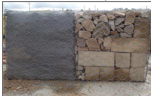
Figura 31 - Gabião construído com reaproveitamento de materiais da construção civil
