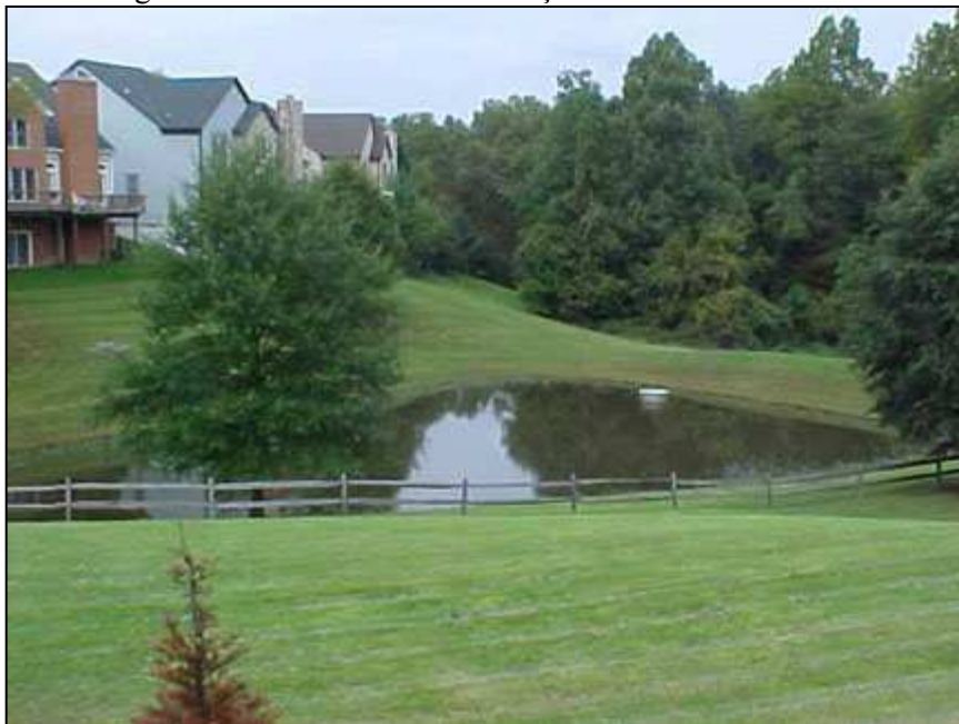
Figura 43 - Reservatório de retenção em bairro residencial
