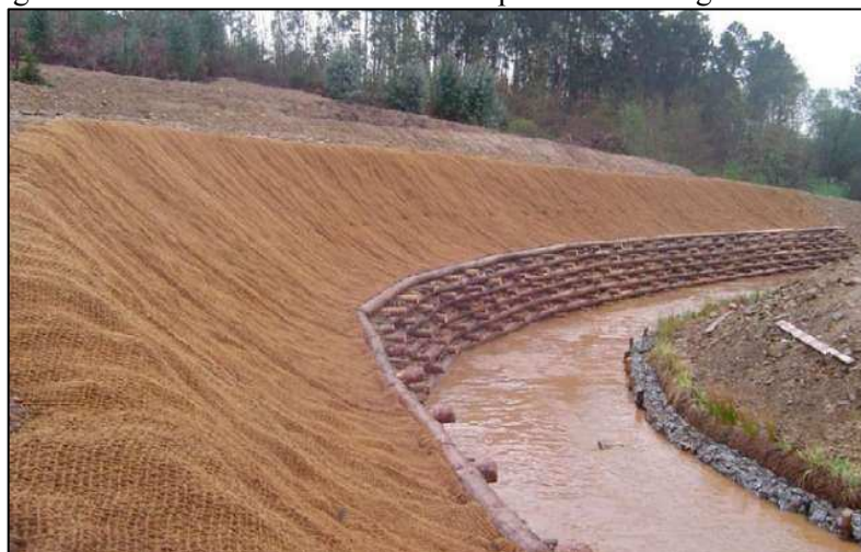
Figura 29 - Biomanta de fibra de coco aplicada em margem de córrego
